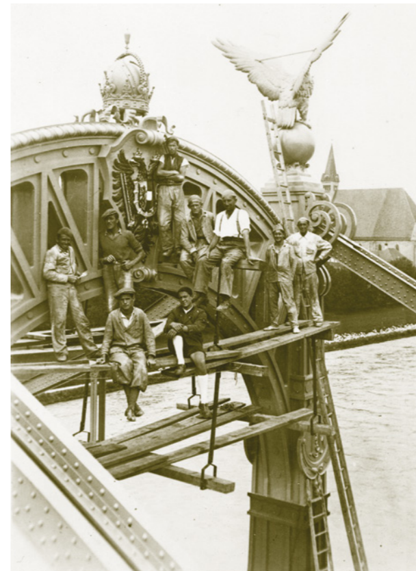
1902/1903 Bau der Länderbrücke
